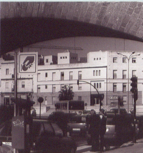
45 · EDIFICIO LA MURALLITA. JULIO MALO DE MOLINA (1995).
