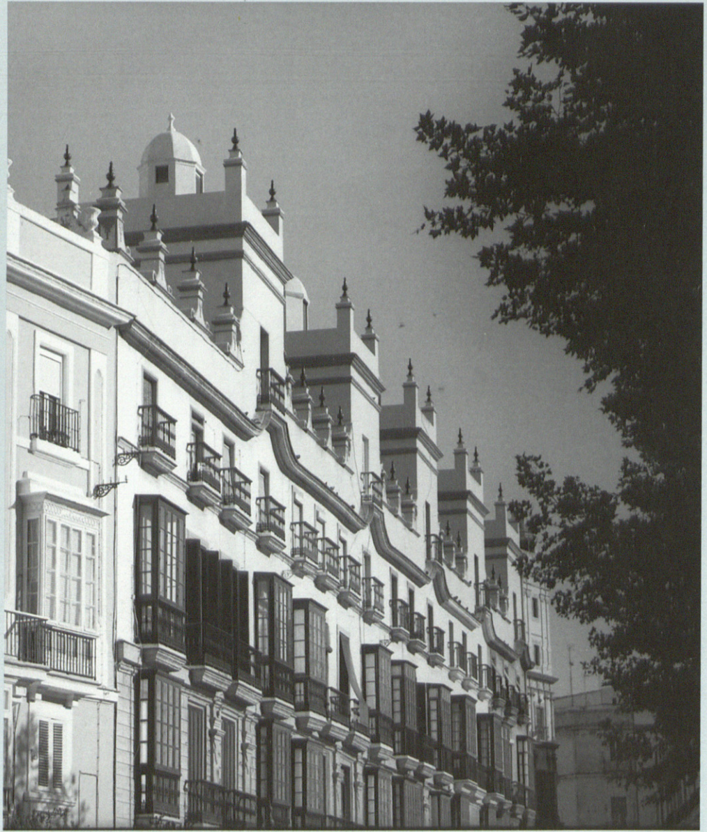
26 - LAS TORRES MIRADOR, QUE CARACTERIZAN LA LÍNEA DEL CIELO DE LA CIUDAD
