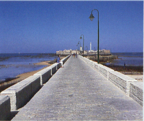
17 · BORDE AMURALLADO: MURALLA DE SAN CARLOS. CAMINO DEL ARRECIFE Y CASTILLO DE SAN SEBASTIÁN. CAMINO DE RONDA Y BALUARTE DE LA CANDELARIA.
